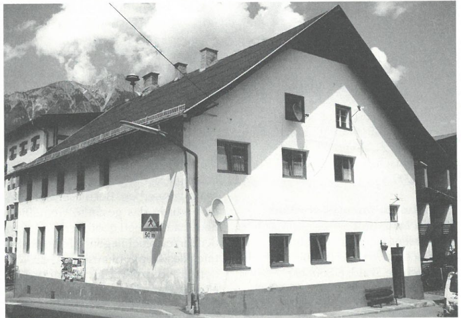
Wird saniert: Das alte Schulhaus.
