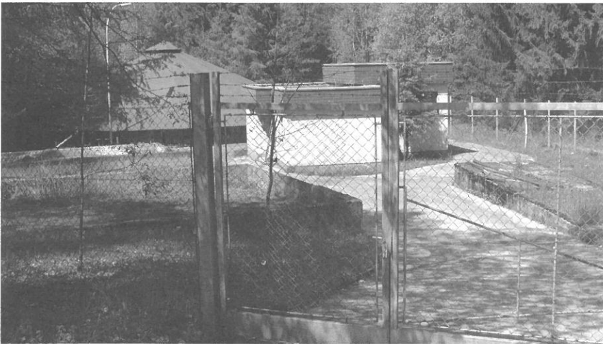
Die Kläranlage in Arzl ist überlastet, das Regenwasser trägt wesentlich dazu bei, wie die starken Regenfälle der vergangenen Wochen bewiesen haben.
