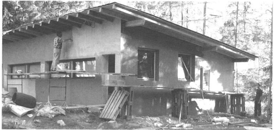
Alle halfen zusammen, damit das Vereinshaus entstehen konnte.
