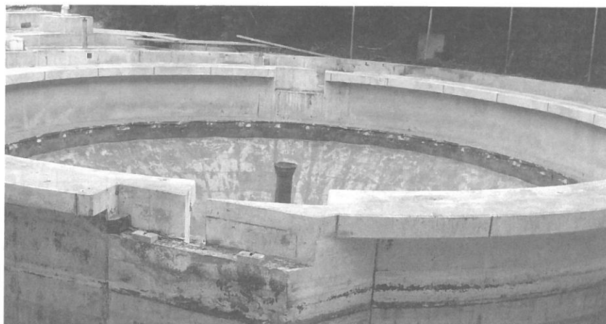
Die bestehende Kläranlage wird zu einer Pumpstation umfunktioniert.
