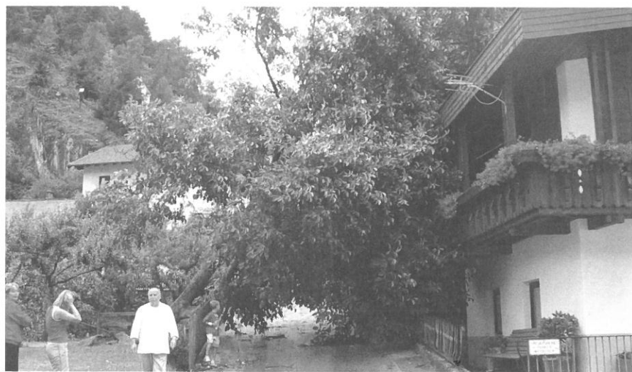
Der große Nussbaum wurde aus seiner Verankerung gehoben und fiel auf das Dach der Familie Greil in Arzl.
