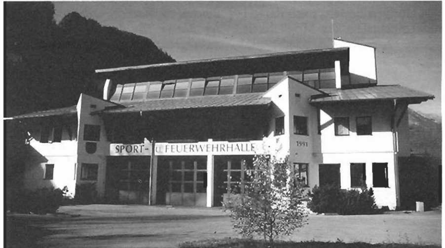
Das Arzler Mehrzweckgebäude sucht einen neuen Namen.
