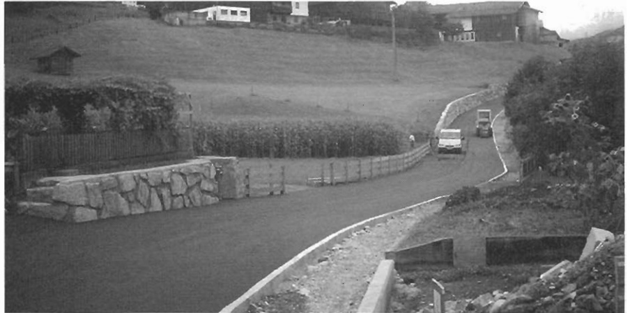
In Wald wurde ein Gehsteig errichtet, gleichzeitig eine Trockensteinmauer erstellt und die Straße neu asphaltiert.
