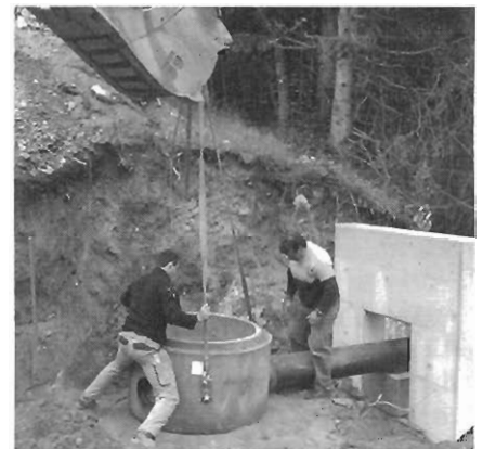
Das Kanal-Baulos 3 konnte abgeschlossen werden.
