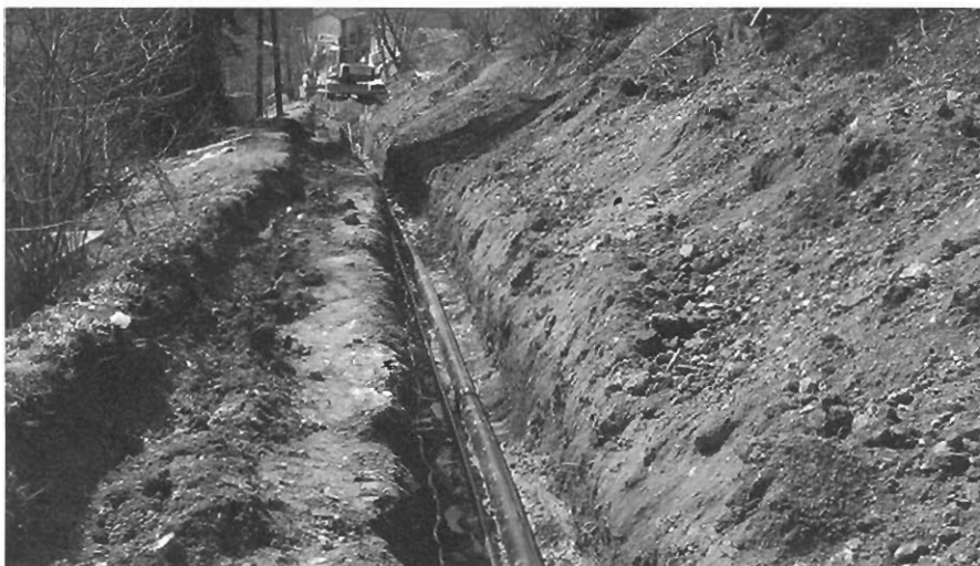
Heuer wurde die Kanalisierung der Weiler Blons, Arzlair und Plattenrain fertiggestellt
