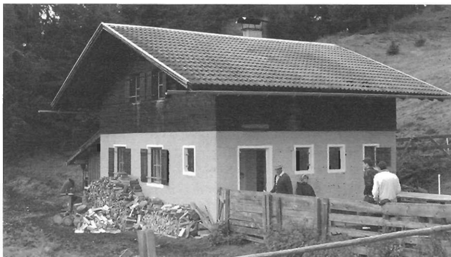
Noch im Herbst, spätestens aber im kommenden Frühjahr wird mit dem Bauarbeiten begonnen.
