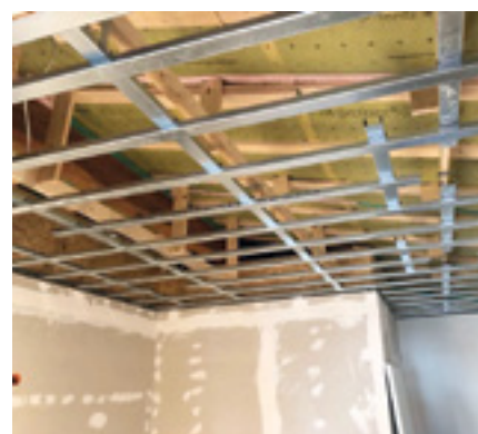
Neue Deckenkonstruktion im Gemeindehaus
