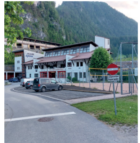
Einfahrt Verboten/ Parkplätze sind für die Feuerwehr freizuhalten
