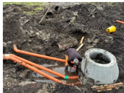
Wald Bichl – Neuverrohrung des Dorf verlaufenden Baches
